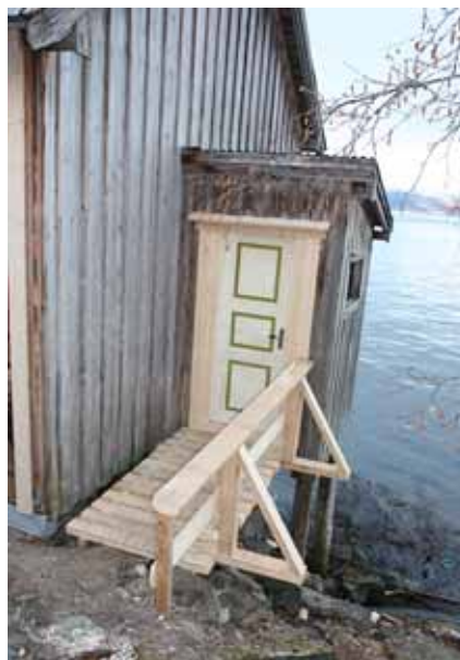
Så var utedoen ferdig og klar til bruk
