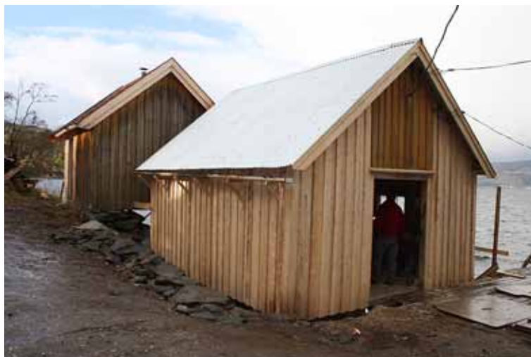
Husene er restaurert
